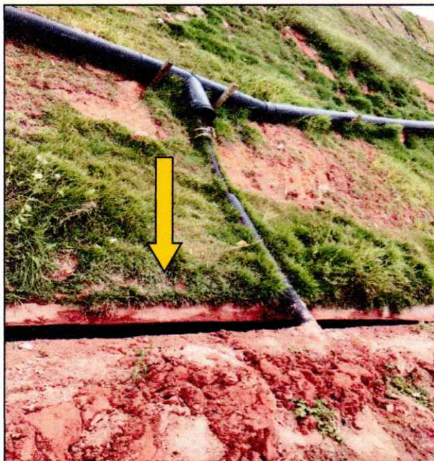
Figuras 3, 4, 5, 6: Vazamento de chorume na canaleta do sistema de drenagem de águas pluviais.
