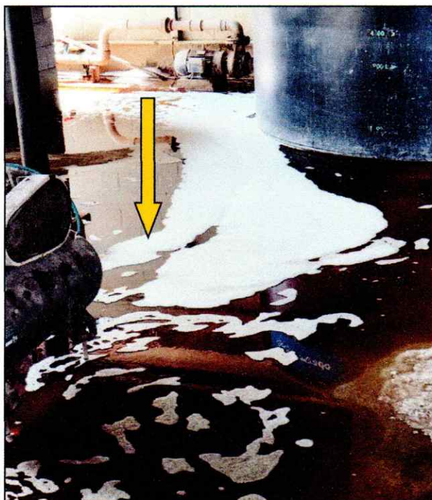
Figuras 16, 17, 18 e 19: Vazamento de chorume na ETE do CTR.
