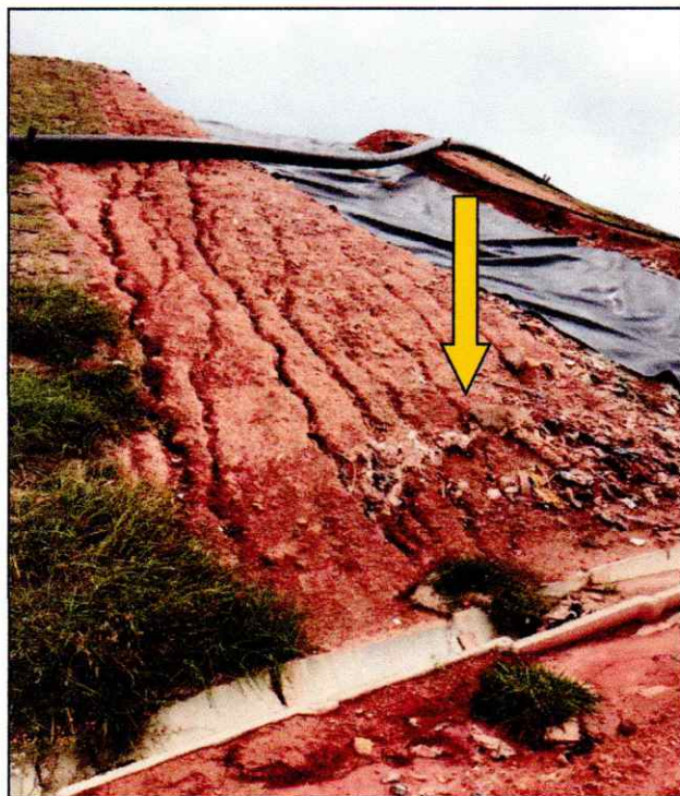
Figuras 7 e 8: Sulcos erosivos nos taludes, sem cobertura vegetal.
