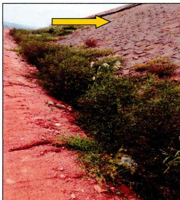
Figuras 7 e 8: Sulcos erosivos nos taludes, sem cobertura vegetal.
