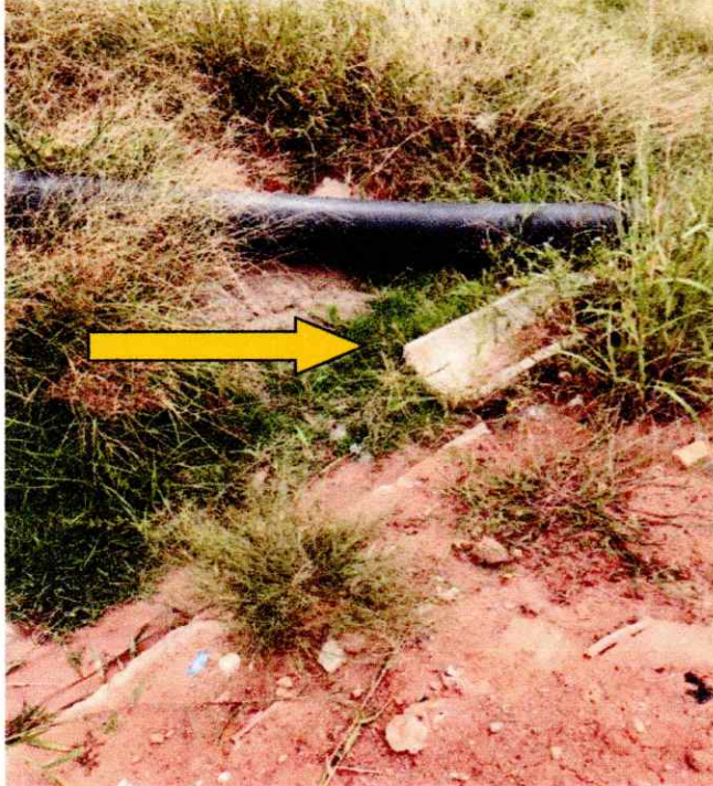
Figuras 9, 10, 11, 12, 13 e 14: Sistema de drenagem de águas pluviais assoreado por material argiloso e vegetação.
