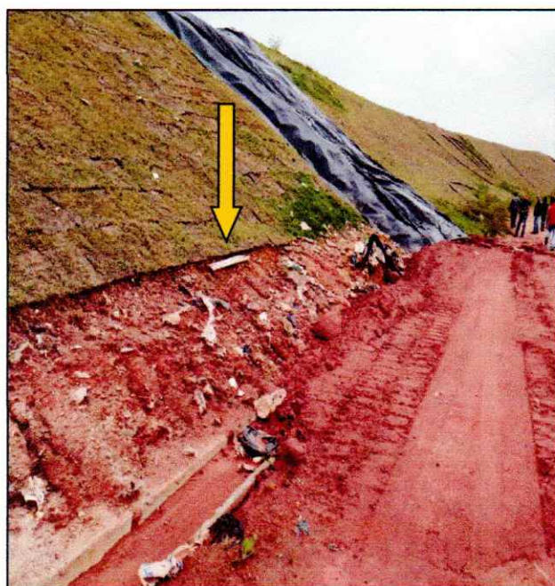
Figuras 7 e 8: Sulcos erosivos nos taludes, sem cobertura vegetal.
