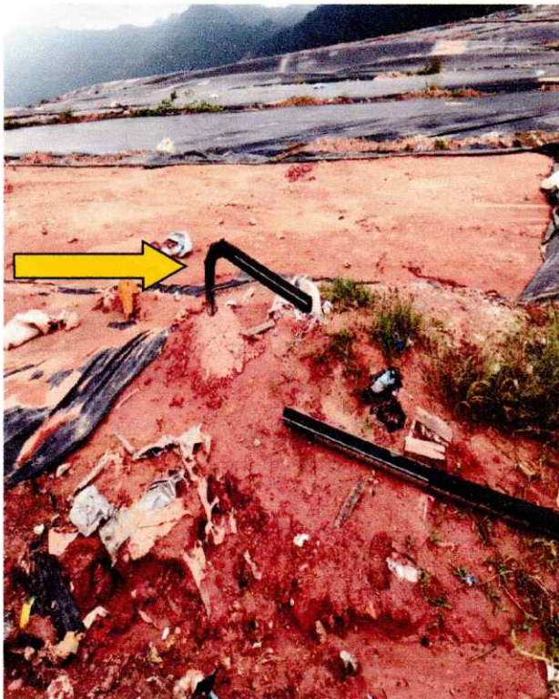
Figuras 14 e 15: Vários pontos de lançamento de Gases direto na Atmosfera, sem nenhum tipo de tratamento, no tópo do Aterro.
